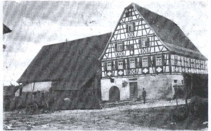
Wohnhaus Wilhelm Häußermann, Heidenhof, 1918
