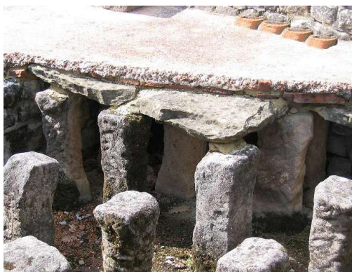
Hypokaustanlage – Boden- und Wandheizung
